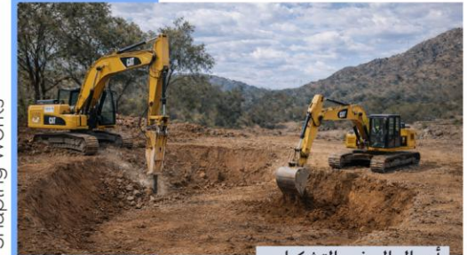
أعمال الحفر والتشكيل
